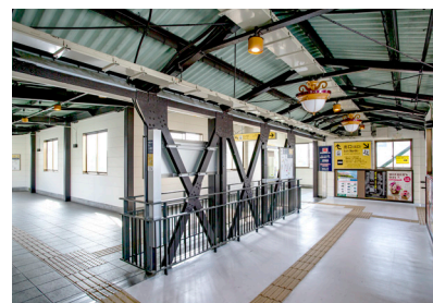
◇ リニューアルを終えた駅構内の跨線橋
