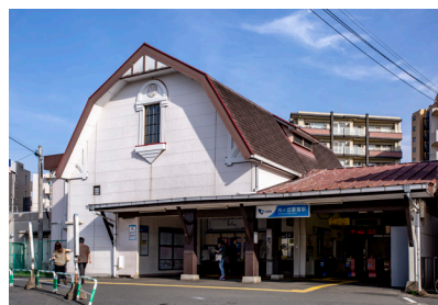
◇ 改修予定の北口駅舎
